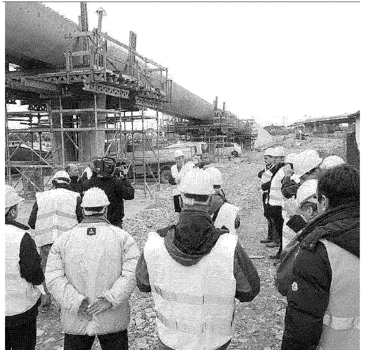
Il cantiere del Pisa Mover durante un recente sopralluogo del sindaco Marco Filippeschi (foto Fabio Muzzi)
