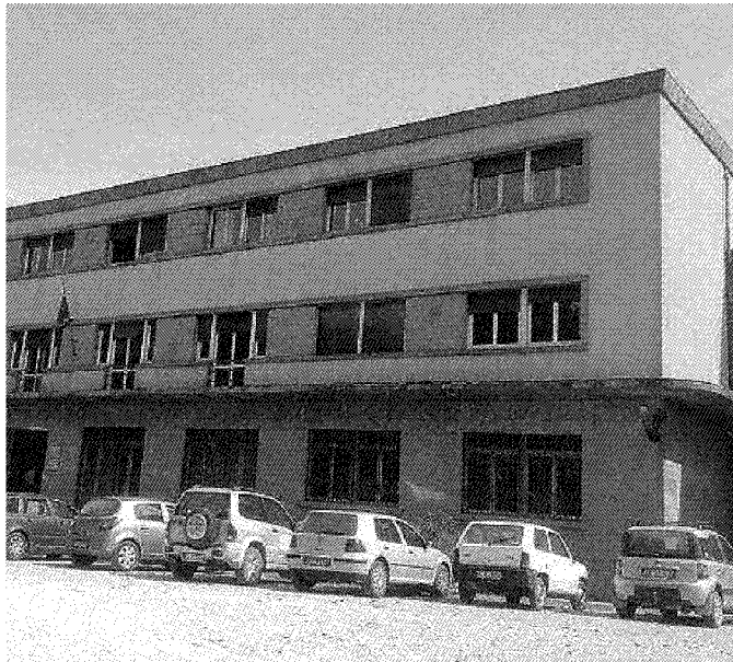
La sede dell'Unione dei Comuni del Monte Amiata
