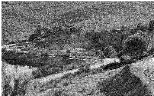
I fanghi rossi della Tioxide nella discarica ricavata nell'ex cava di Montioni
