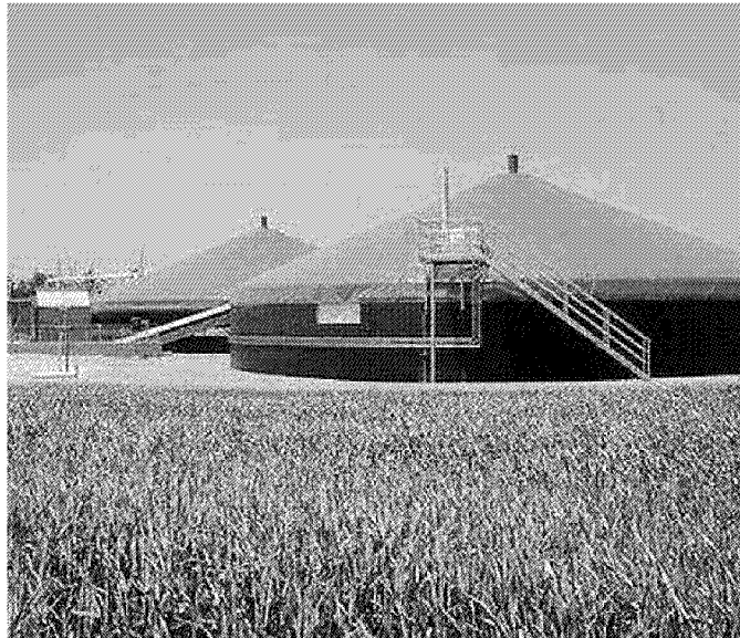
Una centrale a biomasse
