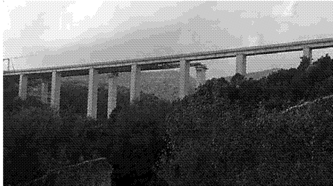
Il viadotto del Petriolo e, dietro, quello in costruzione
