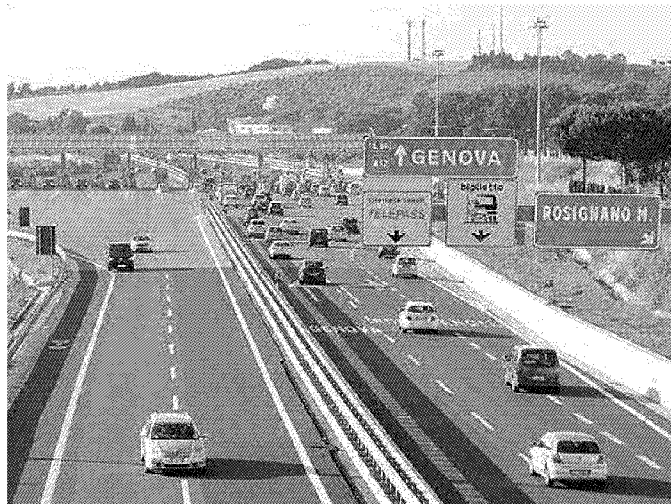
Caselli autostradali a Rosignano
