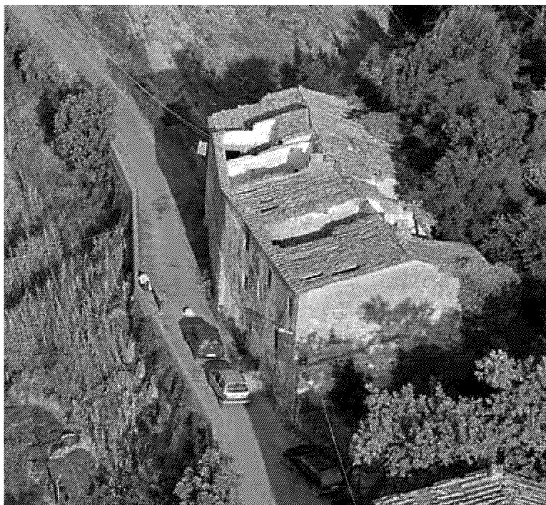
DALL'ALTO Toiano 2 mesi prima del crollo (foto Piero Frassi)
