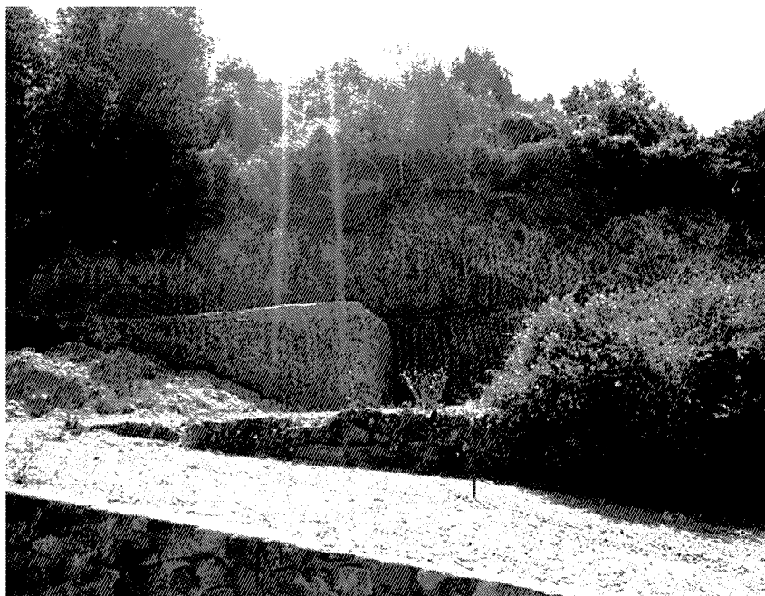
Lo sbancamento alle spalle della spiaggia di Zuccale
