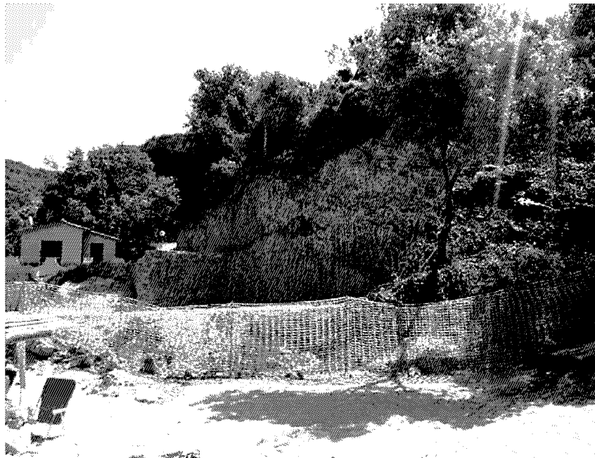
L'area del cantiere sulla spiaggia di Zuccale
