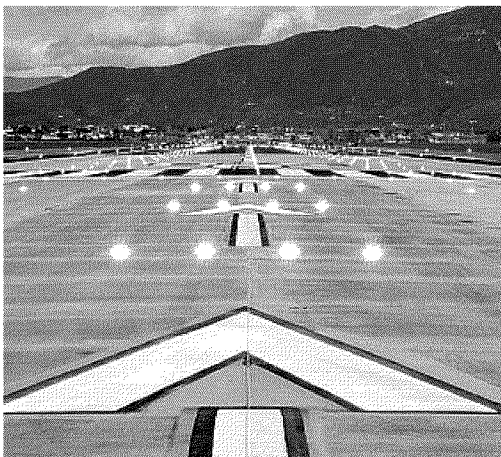
La nuova pista appena realizzata all'aeroporto di Pisa
