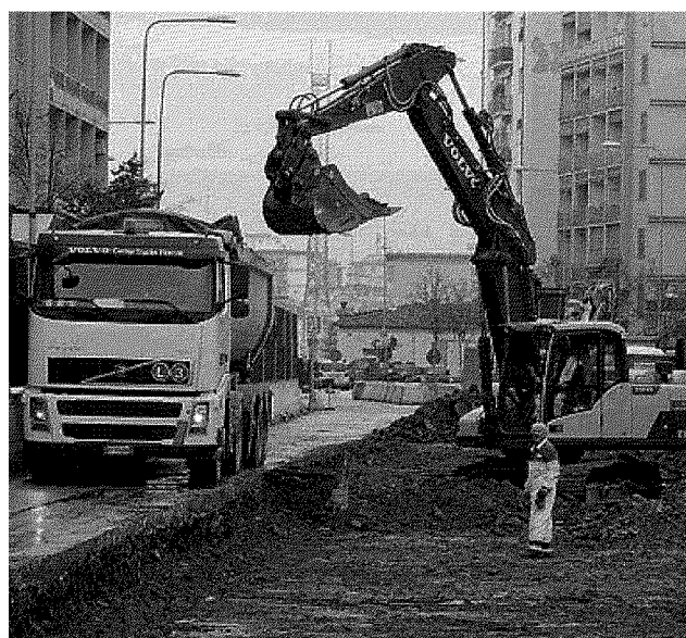
Il cantiere della tramvia in via di Novoli
