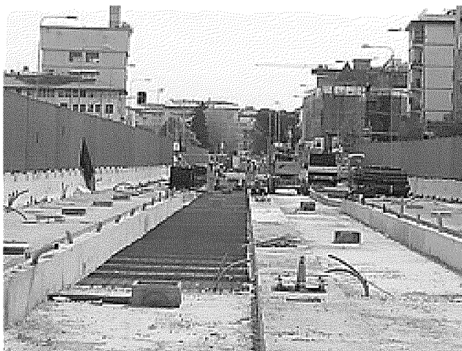
I lavori per la linea 2 della tramvia in via di Novoli
