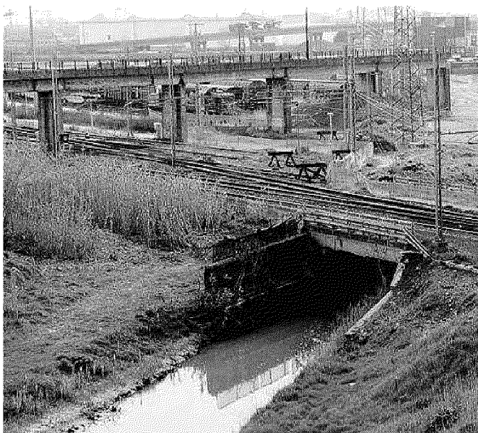
Il cantiere dello "scavalco" (Marzi Pentafoto). In alto: il terminal Tdt
