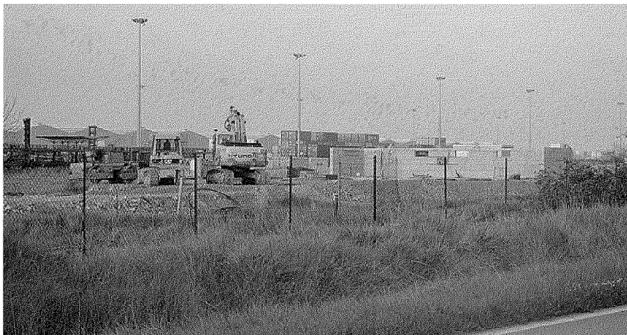
LAVORI IN CORSO Il cantiere della centrale a biomasse lungo la strada «delle Colline» sono già partiti
