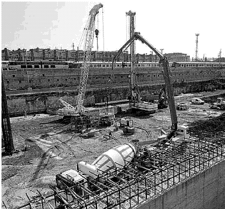
Operai e tecnici al lavoro nel cantiere Tav di via Circondaria
