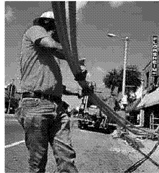
La posa di cavi in fibra ottica
