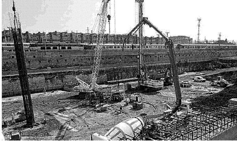
Le gru nel cantiere per la realizzazione della stazione Foster
