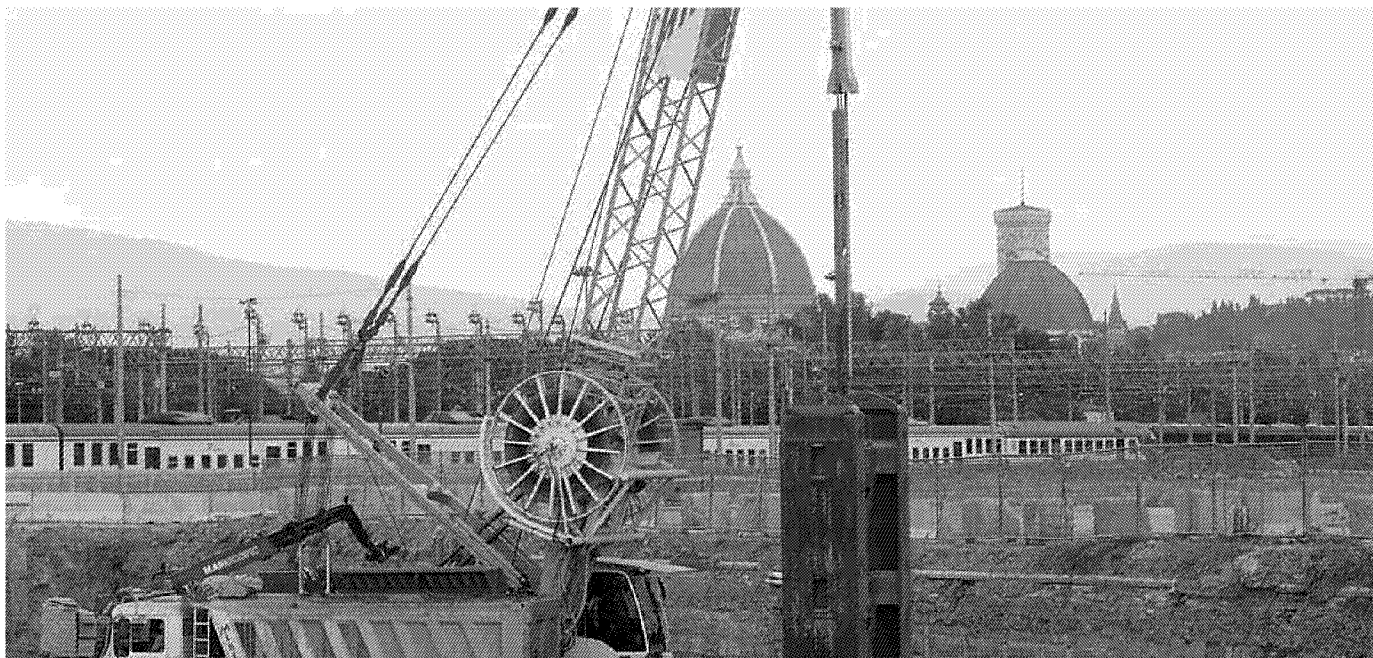
Firenze, cantiere della Tav con la perforatrice (foto Niccolò Cambi / Massimo Sestini)
