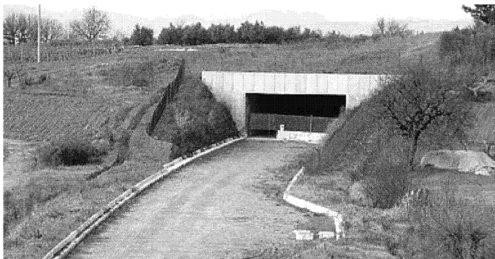
Il tratto di Brusciiana, Empoli, col sottopasso ancora chiuso; in alto il cantiere abbandonato nella zona di Castelfiorentino
