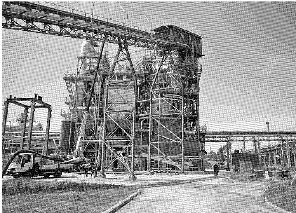
Una parte degli impianti dell'inceneritore di Scarlino (foto Giorgio)
