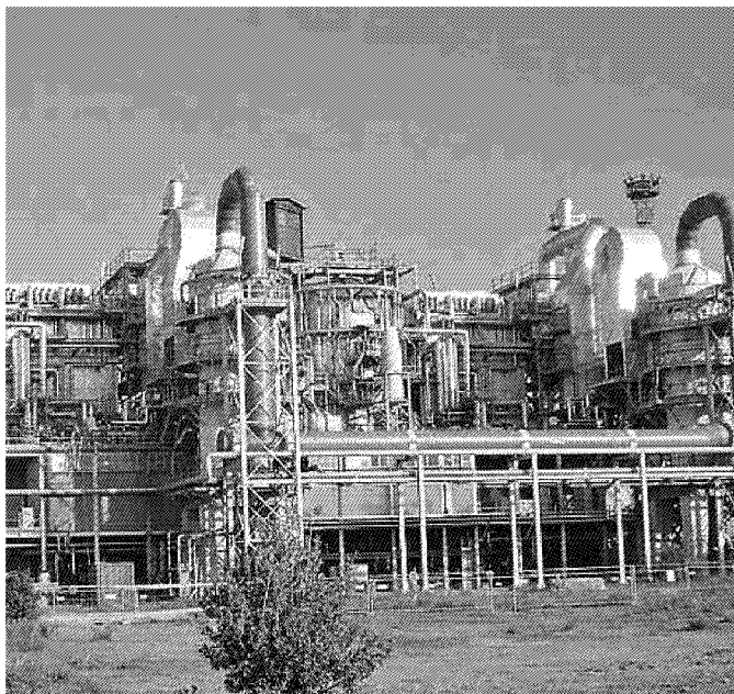
L'inceneritore di rifiuti al Casone di Scarlino
