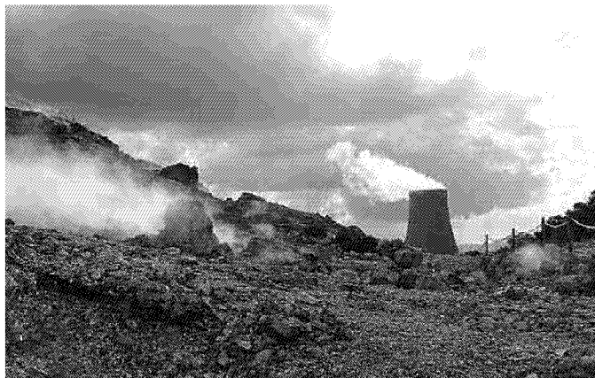
L'impianto geotermico nella zona delle Biancane
