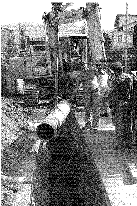
La posa di un tubo dell'acqua
