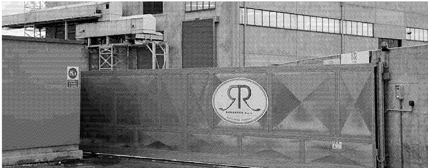
L'ingresso dell'impianto Erre Erre
