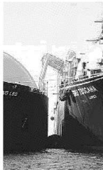
LA STRUTTURA Il rigassificatore off-shore
