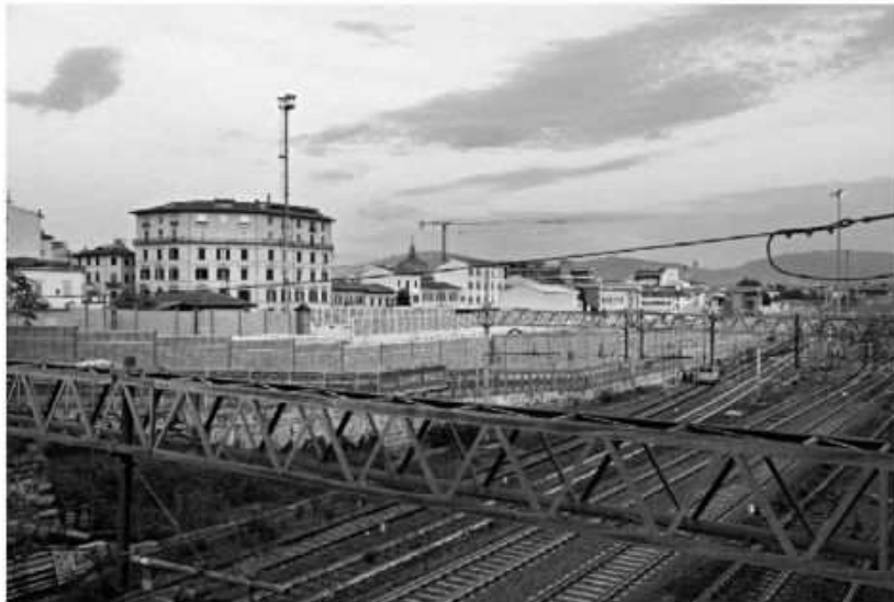
IL CANTIERE DELL'ALTA VELOCITÀ A FIRENZE. SOTTO: DENIS VERDINI. A SINISTRA: RICCARDO FUSI
