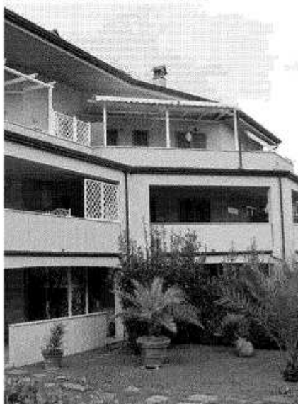
La Residenza turistica attraversata di via delle Cateratte
