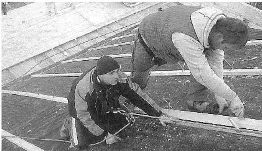
ENERGIA Tecnici all'opera sulla struttura di un impianto geotermoelettrico in costruzione
