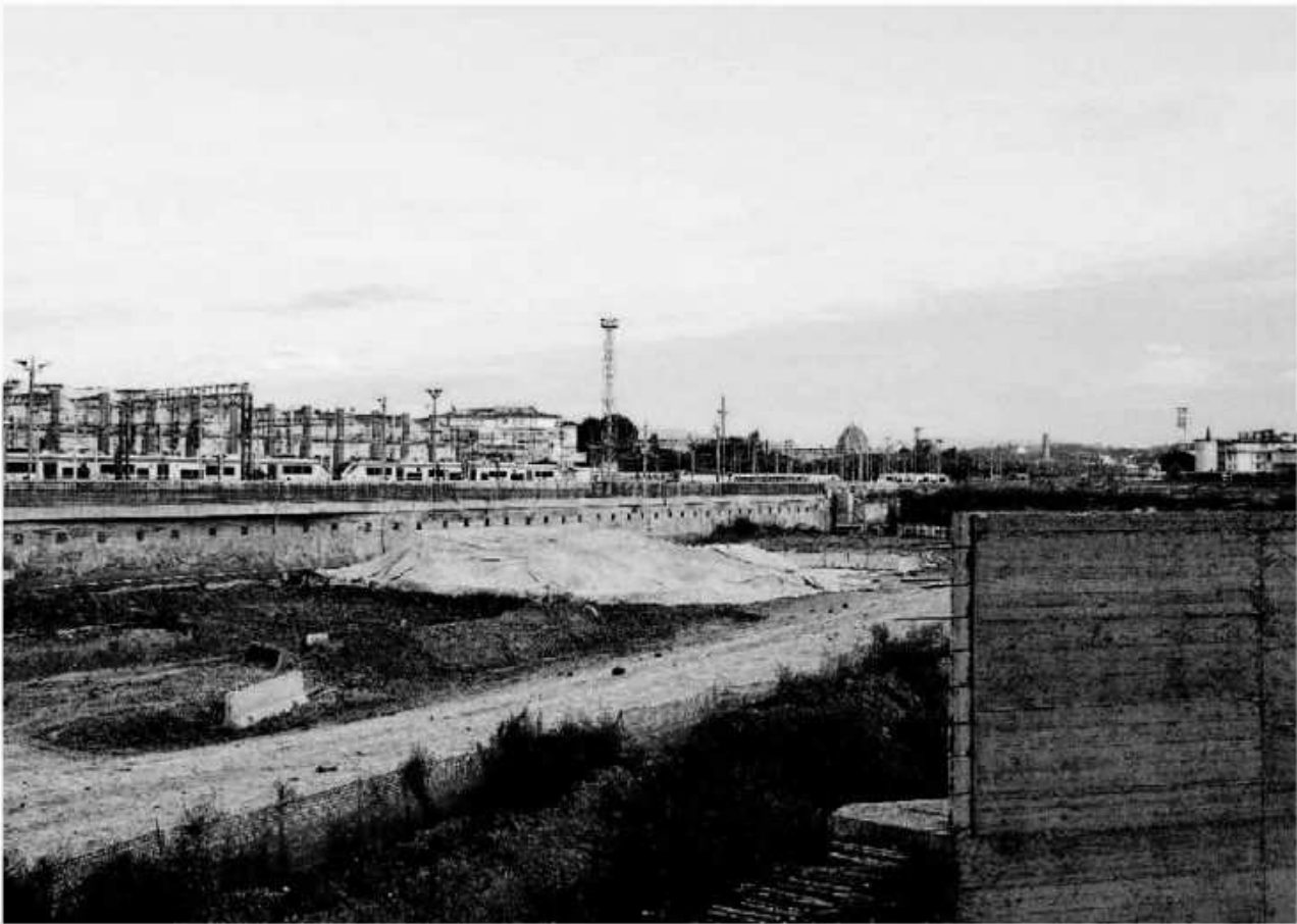
UN'ALTRA VEDUTA DEL CANTIERE PER IL TUNNEL DELL'ALTA VELOCITÀ DI FIRENZE
