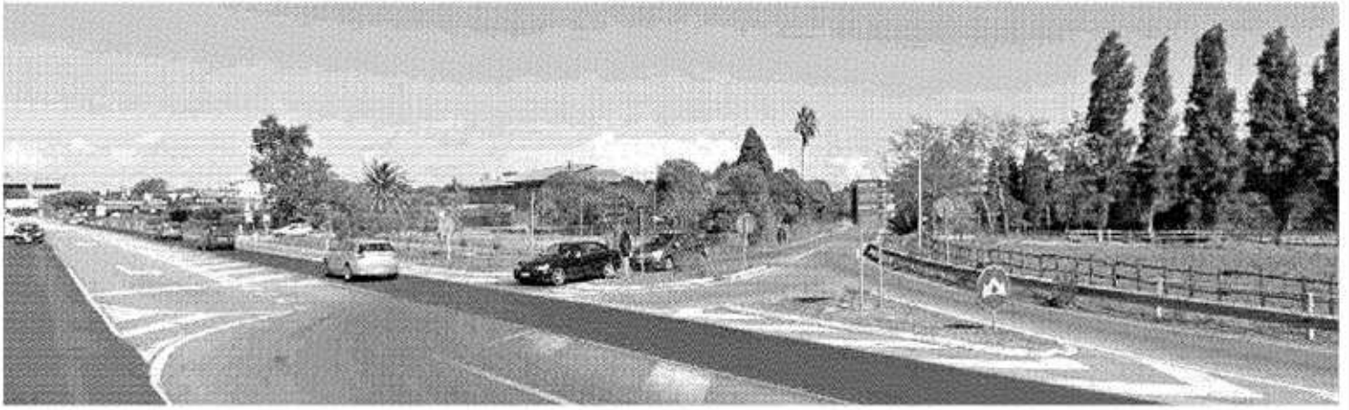
Lo svincolo dell'Aurelia nei pressi di Orbetello, uno dei tratti su cui ancora non si è trovato l'accordo sul tracciato
