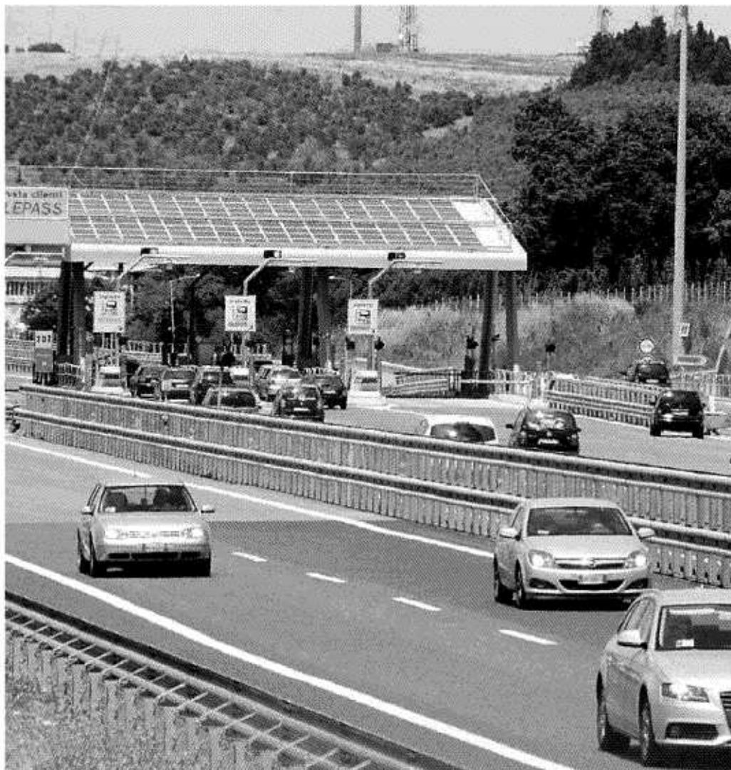
Il casello di Vada, monumento all'incompiuta
