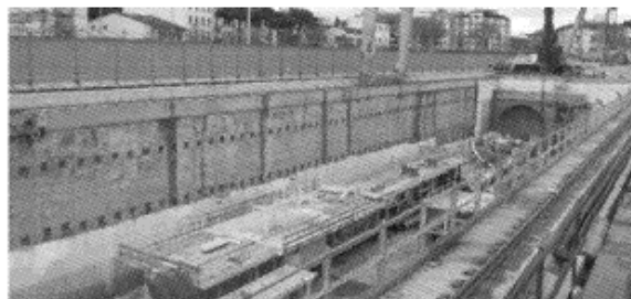
I lavori del sottoattraversamento dell'Alta Velocità a Firenze
